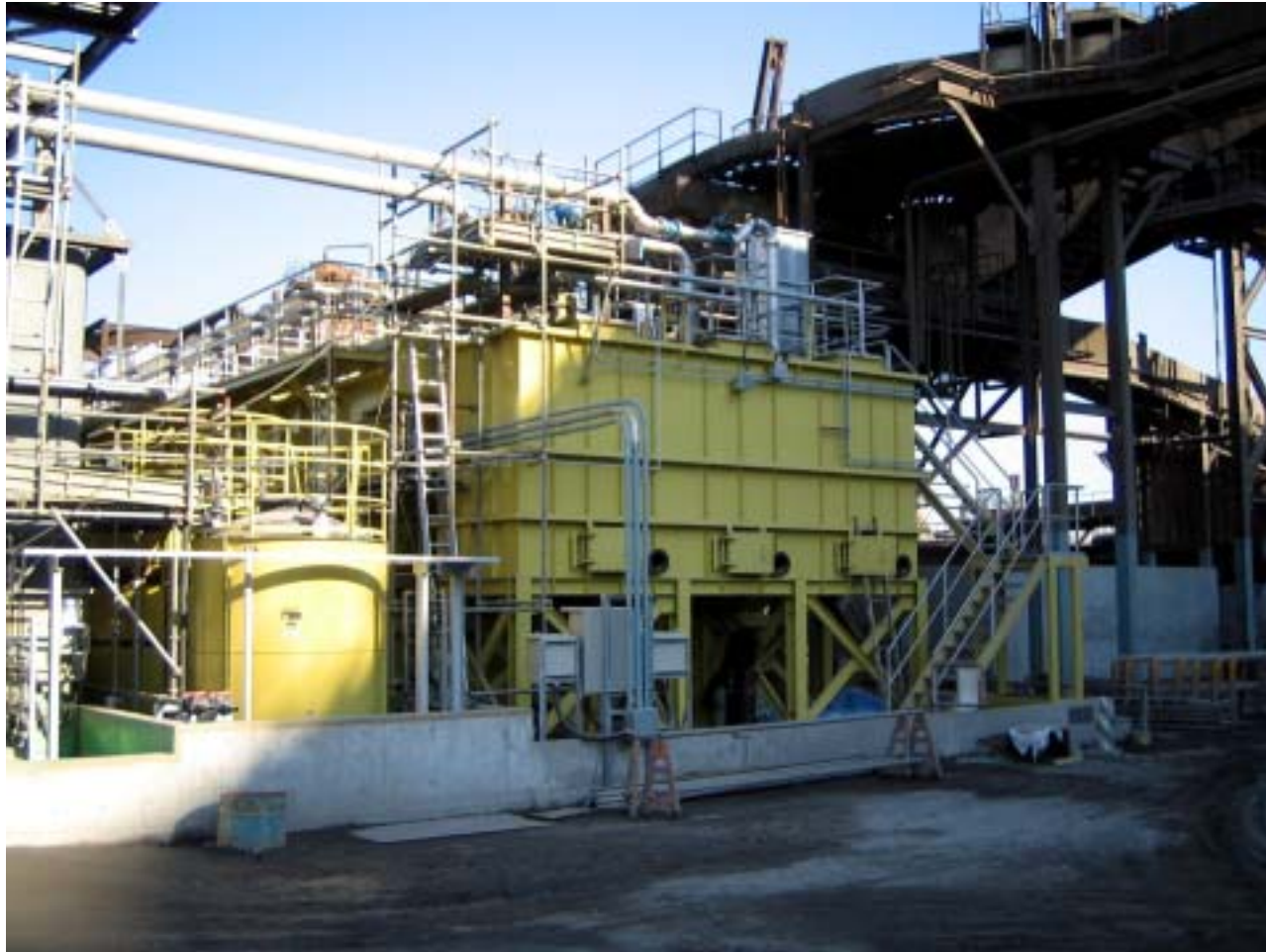
新沈殿池全景
